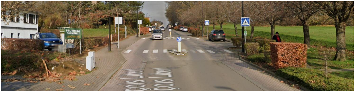
Tronçon sud de la rue François Libert (Source: Google Maps)
